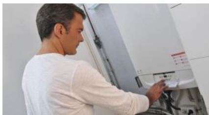
Caldera de gas en un domicilio particular.
